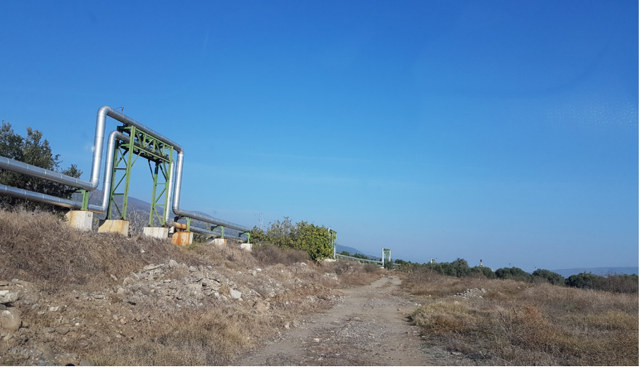
Pamukören'de tarım arazilerinden geçen jeotermal akışkan iletim boruları. K. Kutlu
