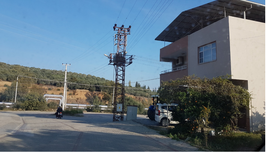
Pamukören'de yerleşim alanlarından geçen jeotermal akışkan iletim boruları. K. Kutlu
