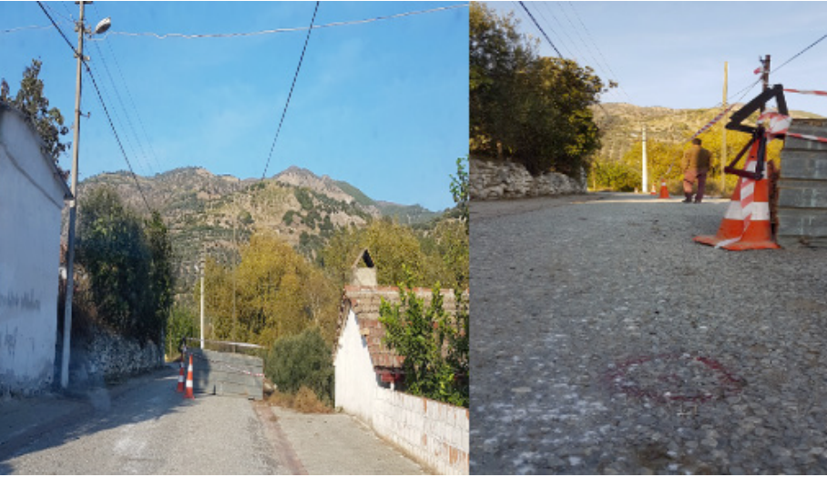
Pamukören'de bir bölümü bariyerle kapatılan yol ve yetkililerin ölçümler sonucunda yaptığı arazi sınırı işaretlemeleri. K. Kutlu
